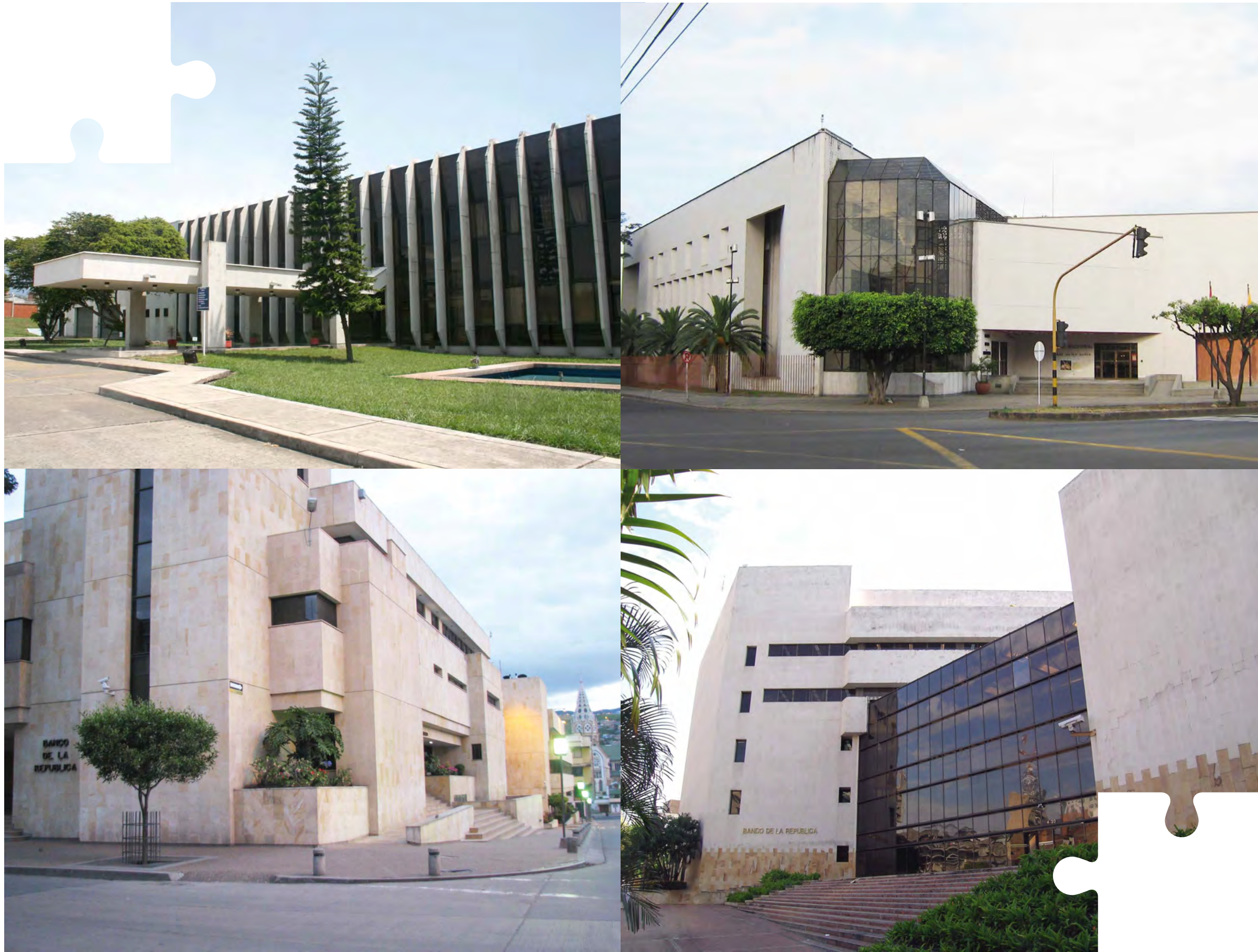
Izquierda superior: edificio de acuñación, Fábrica de Moneda (Ibagué). Derecha superior: Sucursal Cúcuta. Izquierda inferior: Sucursal Pasto. Derecha inferior: Sucursal Cali.
